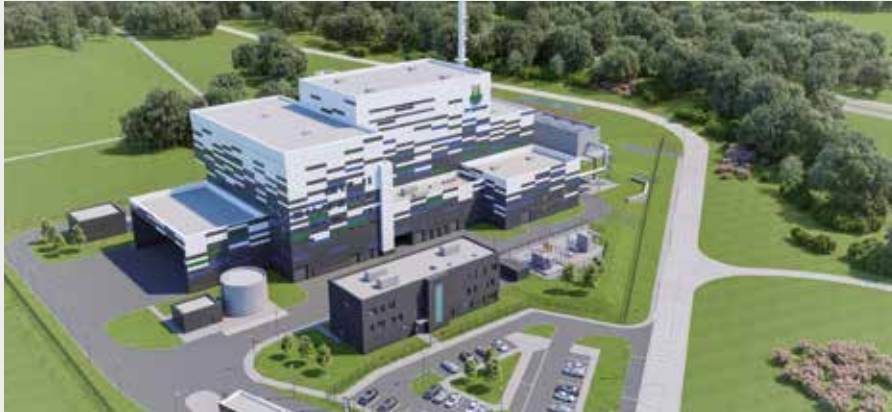
Chaufferie CSR d'une capacité de 160 000 tonnes par an.
